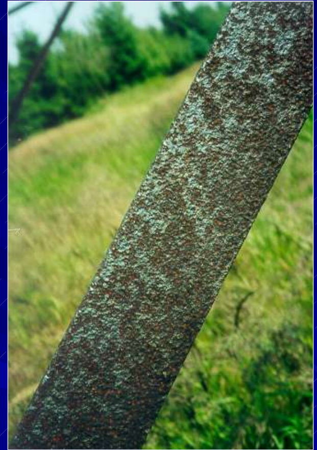
Méně ochranná patina na patinující oceli
