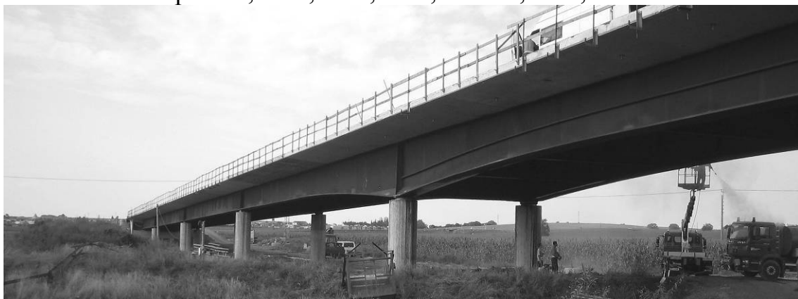
Obr. 10– Nosná konstrukce mostu přes řeku Opavu na Opavské spojnici
