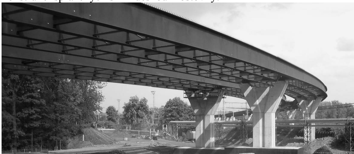
Obr. 9– Ocelová konstrukce mostu přes ČD na Severním spoji v Ostravě
