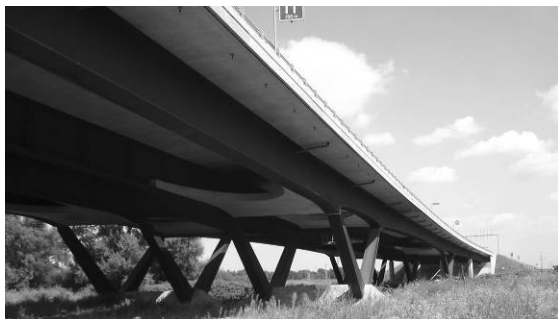
Obr. 11-16– Mosty z oceli atmofix na dálnici D47
