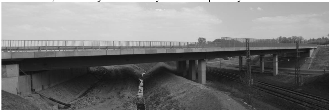
Obr. 8– Most přes trať ČD na přivaděči Bělotín
