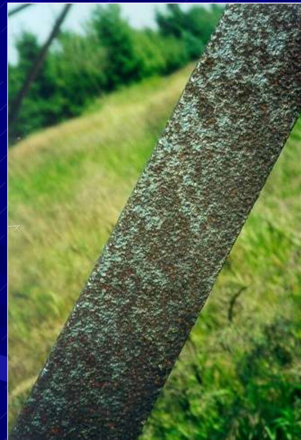
Méně ochranná patina na patinující oceli
