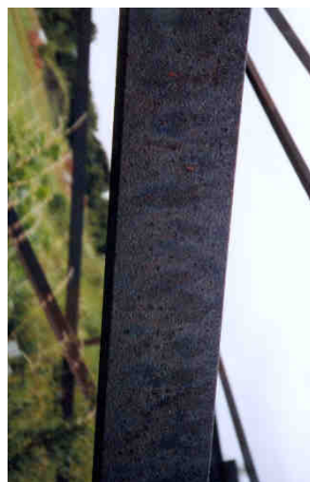
ochranná vrstva patiny na patinující oceli
