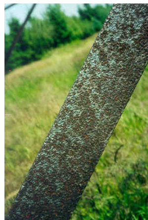
méně ochranná vrstva patiny na patinující oceli
