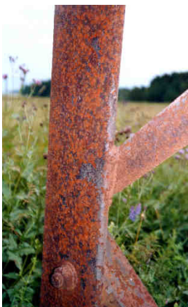
vrstva rzi na konstrukční uhlíkové oceli
