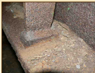
železniční vlečka, Krnov (1979)
