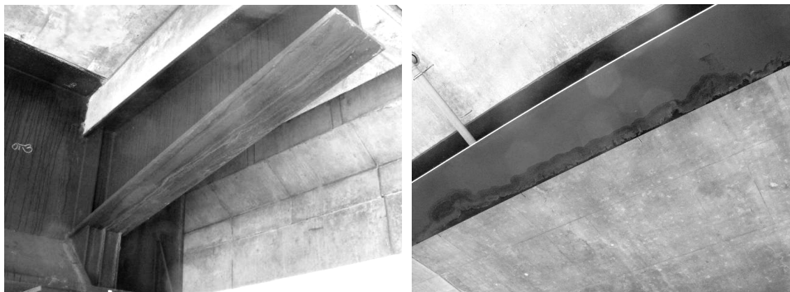
Obrázek 6 – Nepříznivý vývoj patiny na konstrukcích po 2 letech expozice
