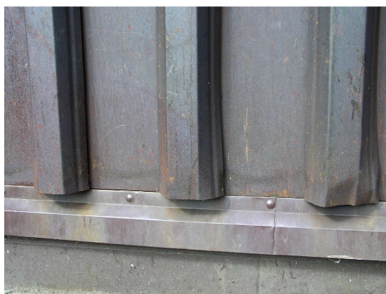
Obrázek 4 – Objekt Obchodního domu v Liberci a detail zakončení opláštění
