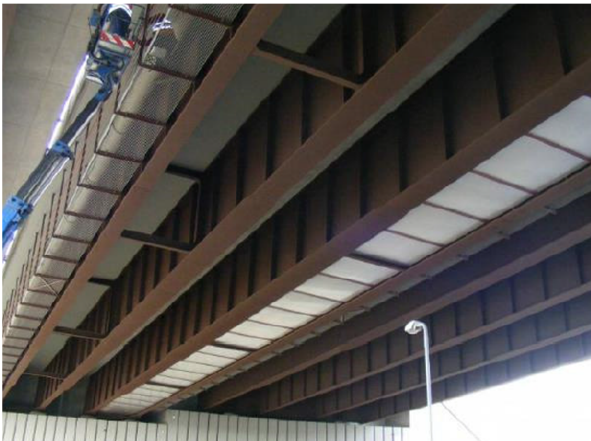
Pohled na OK mostu2
