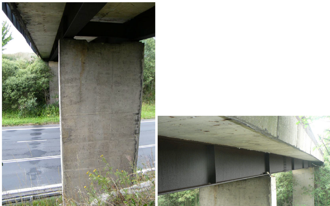
Pohledy na OK mostu1
