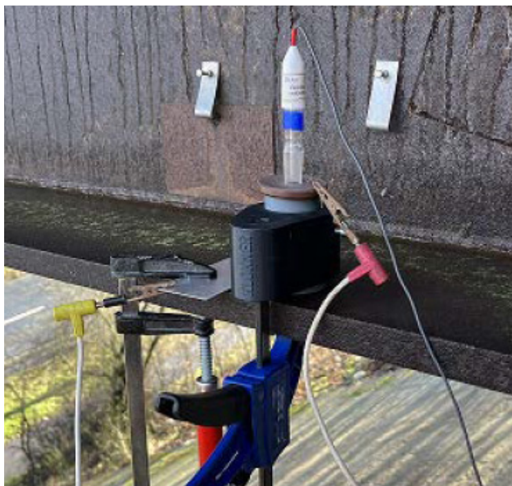
Obr. FV 17. Měření EIS charakteristik (řádového specifického odporu) na OP 4 (horní povrch dolní pásnice) – čtvrtý nosník (pravá strana) - MOTOL
